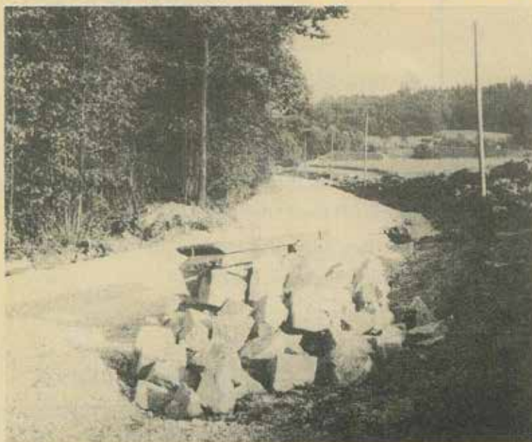
Mit einem Aufwand von 1,5 Millionen Schilling baut die Gemeinde den Güterweg Reingrub, der die Ortschaft Grub von der Wallerer Bundesstraße 134 her neu erschließen wird. WZ-Foto
